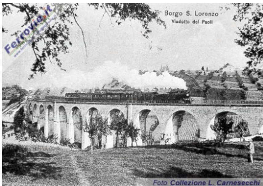
Borgo San Lorenzo - Viadotto
